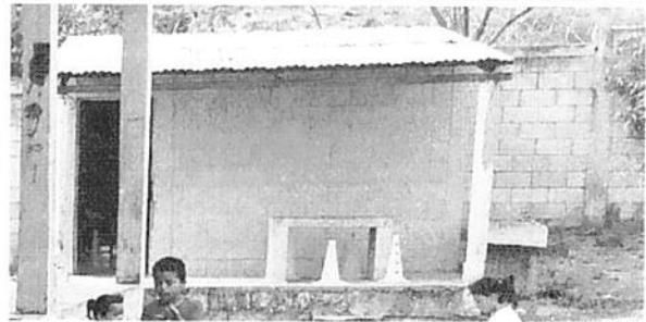
Foto 4: Area para sustitucion de pila
