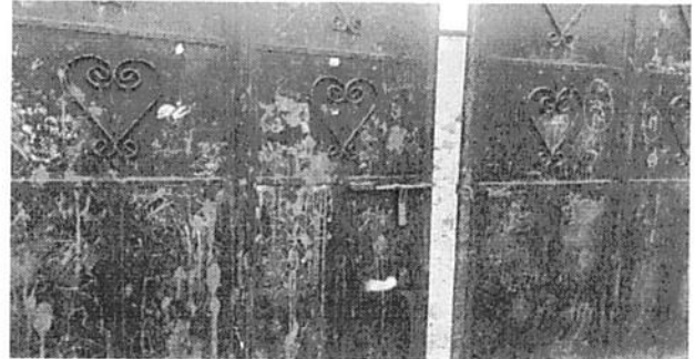
Foto 2: Reparacion de porton de ingresos
