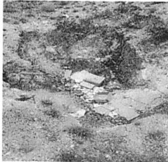
Foto 1: Area para sustitucion de fosa septica
